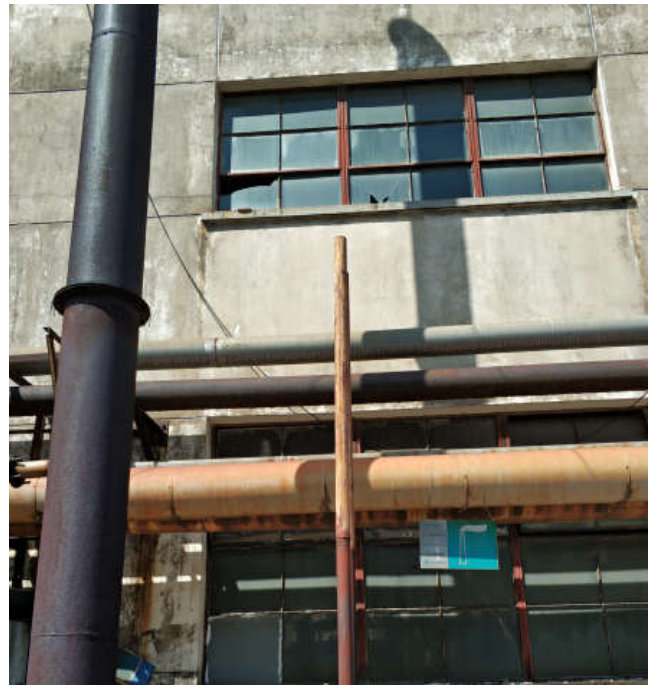
锅炉烟囱废气排放口
