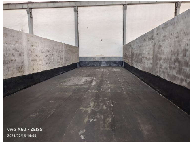
危险储存间地面防渗工程
