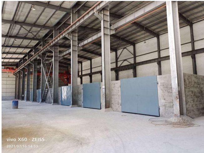
新危废临时贮存场（扩建氧化铝仓库西北部）
