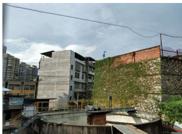
污水处理一站事故应急池（615m 3 废水沉淀池）
