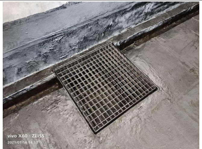
危险储存间泄漏收集池
