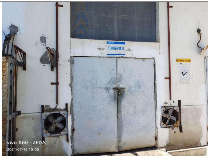
乙炔瓶储存间
