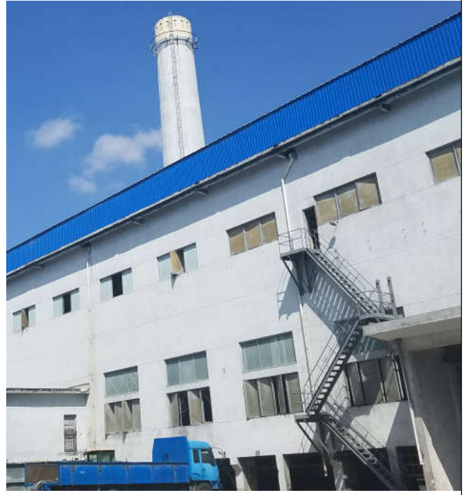
70m 电解车间烟囱（废气排放口）
